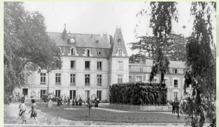
Un des bas-reliefs installé dans le parc de Baillet, 1938-1939 © DR, coll. IHS CGT métaux
